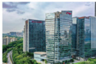
深圳大湾区总部·深圳李宁中心
